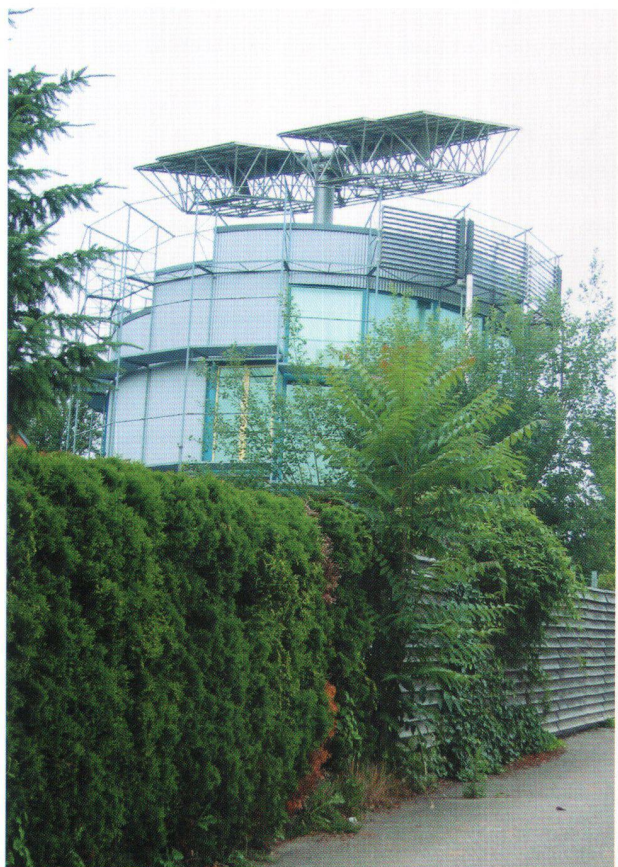
L'Heliotrop house et ses panneaux solaires, comme des symboles annonciateurs de la maison à bilan énergétique positif, trônant sur la terrasse en attique de la maison.
