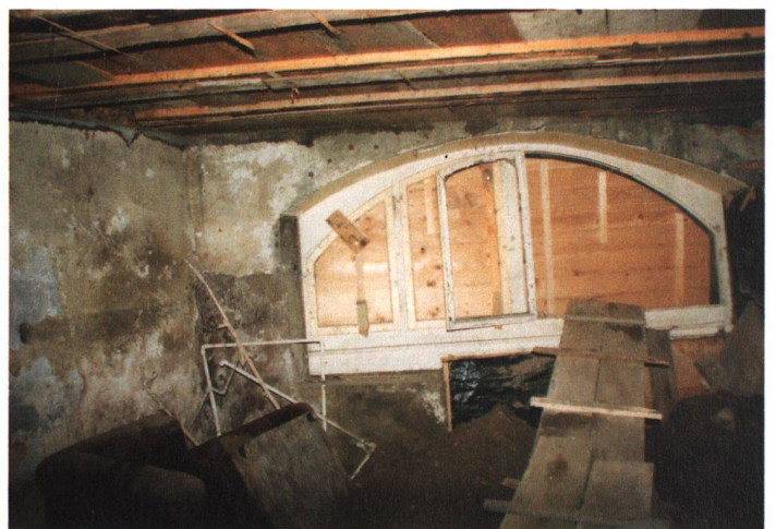
Une chambre côté rue, avant, pendant et après les transformations de l'intérieur et de l'extérieur
