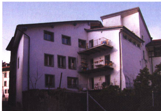
La façade est après la transformation
