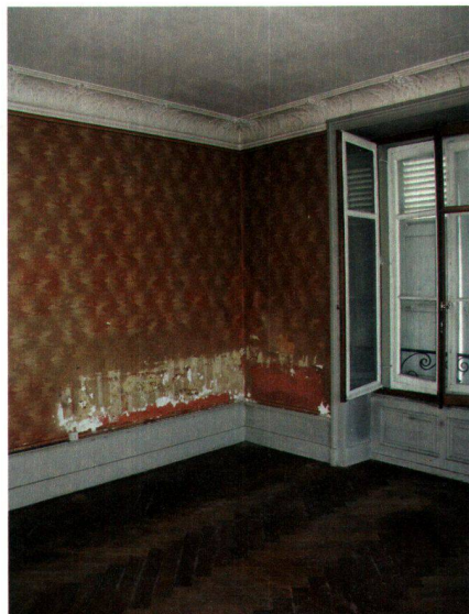
Une chambre avant les travaux.
