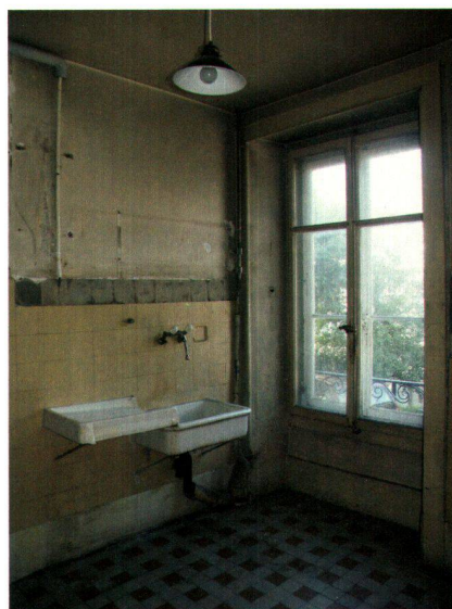
Une cuisine avant les travaux
