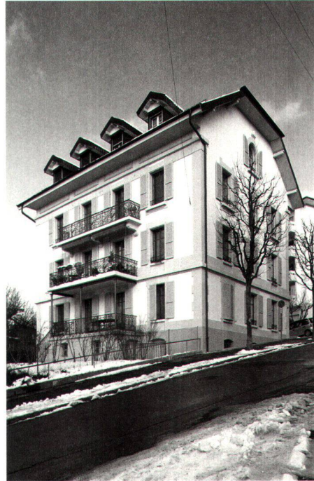
Vue extérieure après les travaux
