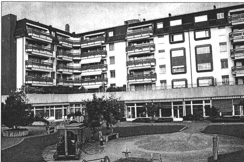
Le complexe locatif du Panorama à Vevey comprend notamment cinq appartements protégés pour les personnes âgées. Celles-ci trouvent sur place un centre de rencontre au rez-de-chaussée où elles peuvent prendre un repas et qui accueille diverses animations. Panorama abrite aussi le centre médico-social de la région et une unité d'accueil pour écoliers.
