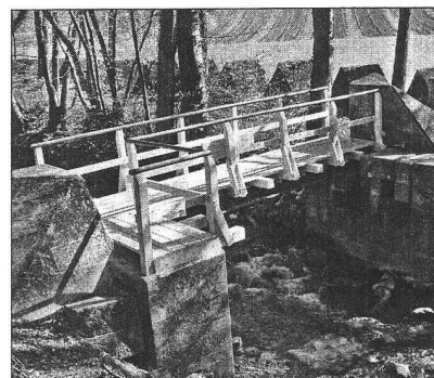
Passerelle du Moulin du Creux après transformation du barrage
