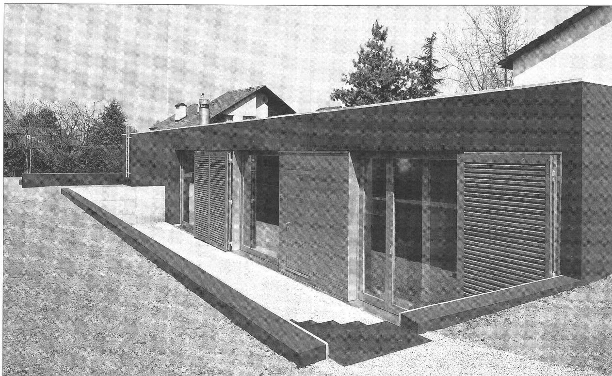
Ci-dessous : la façade sud
