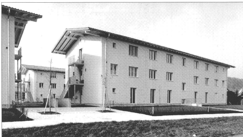
Construction neuve, habitation Altmattweg à Strengelbach (AG), architectes, Hannes Ineichen, Lucerne Coût de construction Fr. 2'500,-/m 2 SUP
