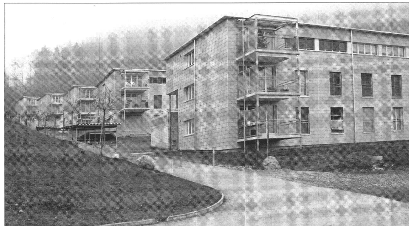
Construction neuve, habitation quartier Fuchsloch à Oberwil (ZG) Coût de construction Fr. 2'700,-/m 2 SUP
