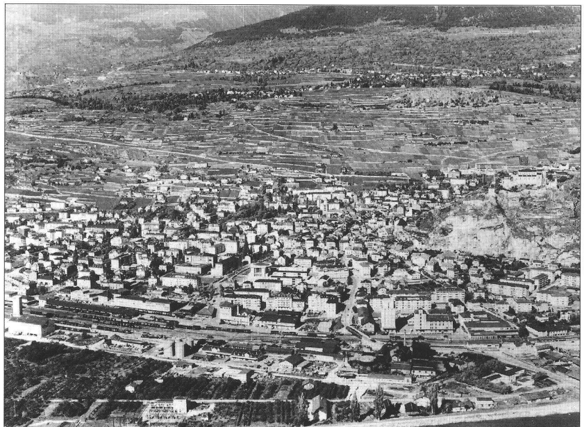
Vue de la ville vers 1960, avec les abattoirs, en bas à droite sur l'image (Photo Archives municipales, Sion)
