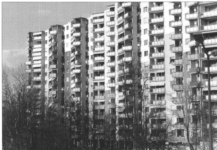
Avanchet-parc : ces 126 logements au milieu d'un parc constituent l'un des joyaux du trésor FOMHAB. Un ensemble de très haute qualité que les travailleurs habitent avec autant de plaisir que leurs voisins en PPE. (photo a)
