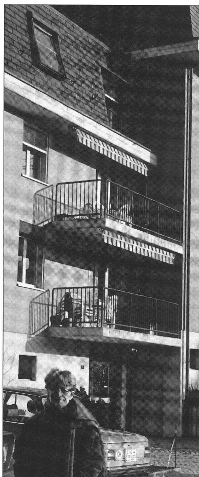
Lycette Schneider, cheveux courts et taille « minçolette », au pied de l'immeuble dont elle fut l'une des promotrices.
