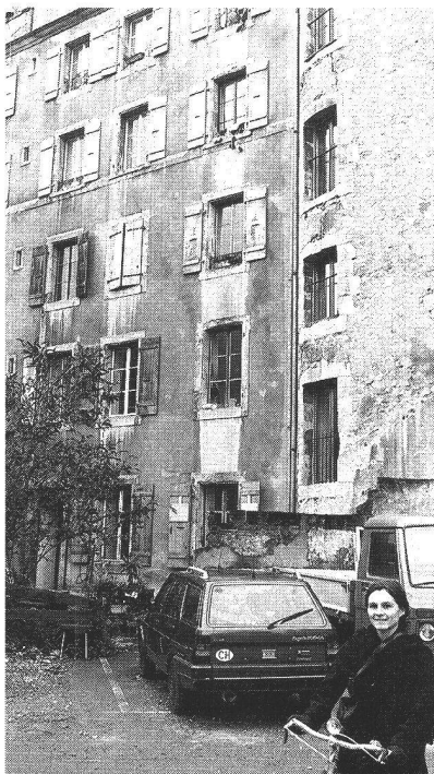
Ci-dessus, les « arrières » du 24 Montbrillant
