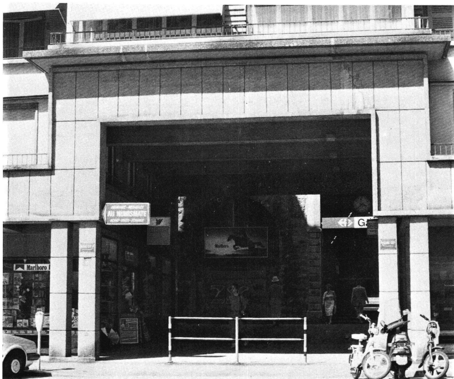
Vue du passage sous le bâtiment
