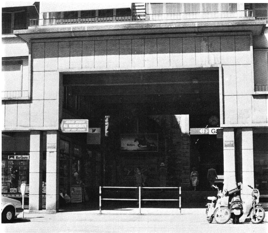
Vue du passage sous le bâtiment
