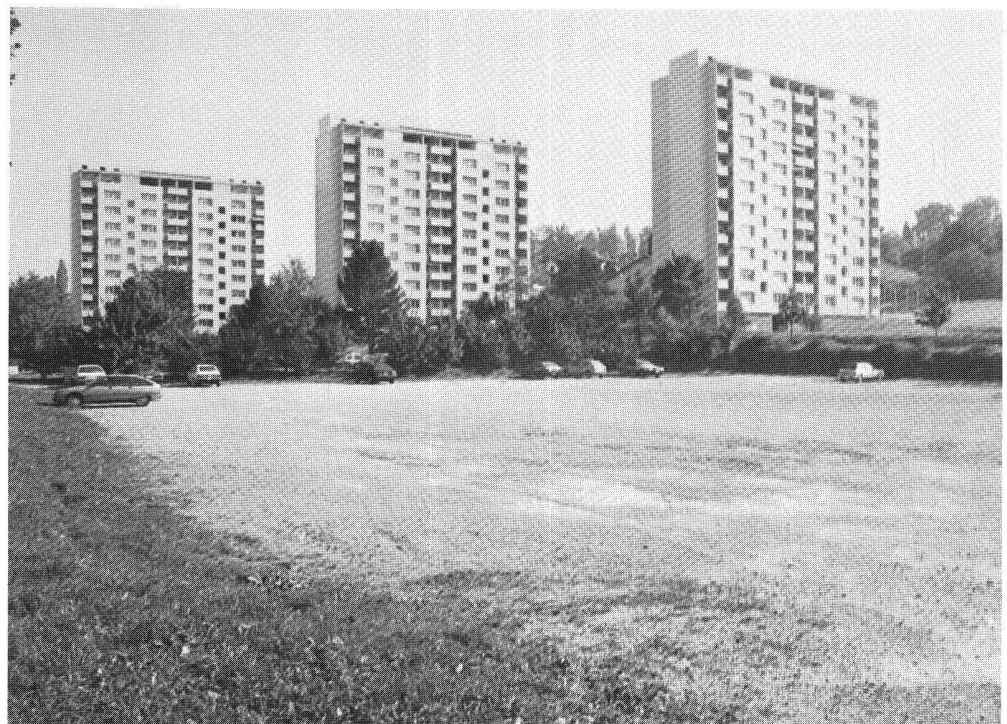
SOLIDARITÉ, Coopérative d'habitation, Fribourg, route du Jura, 3 immeubles d'habitations collectives subventionnées
