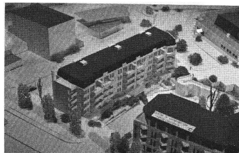
Construction en voie d'achèvement en 1990, réalisée par la Société Coopérative d'habitation de Pully
