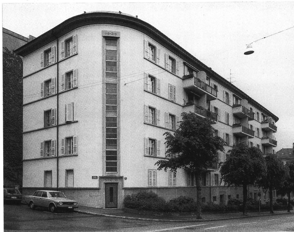
Vue de l'angle arrondi et de l'escalier côté nord.
