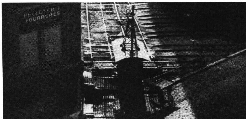
*Le chariot transbordeur fut d'abord actionné par un attelage de chevaux, remplacé en 1890 par un câble rattaché à un moteur hydraulique; en 1907, le chariot est dédoublé et électrifié. Au fur et à mesure du développement du quartier, la voie médiane est prolongée et de nouvelles voies transversales installées. Définissant le mode d'occupation du sol, il contribue à faire de ce quartier ce que certains nomment le «Chicago lausannois».*
