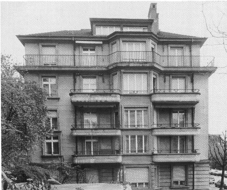
Vue de la façade ouest.
