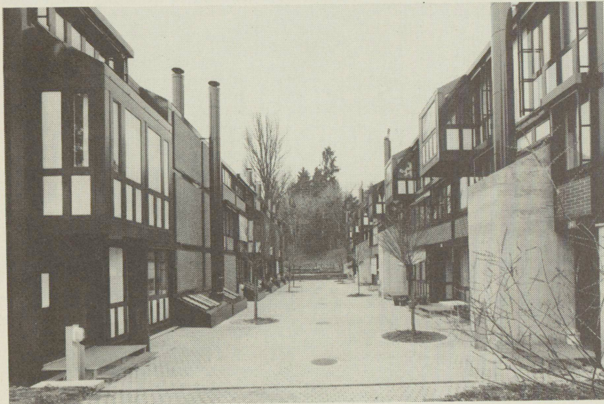
Ruelle de logements dans l'ancien paddock.
