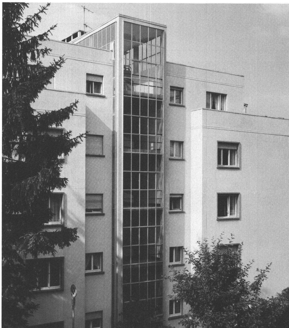
Vue de l'entrée et de la cage d'escalier vitrée.
