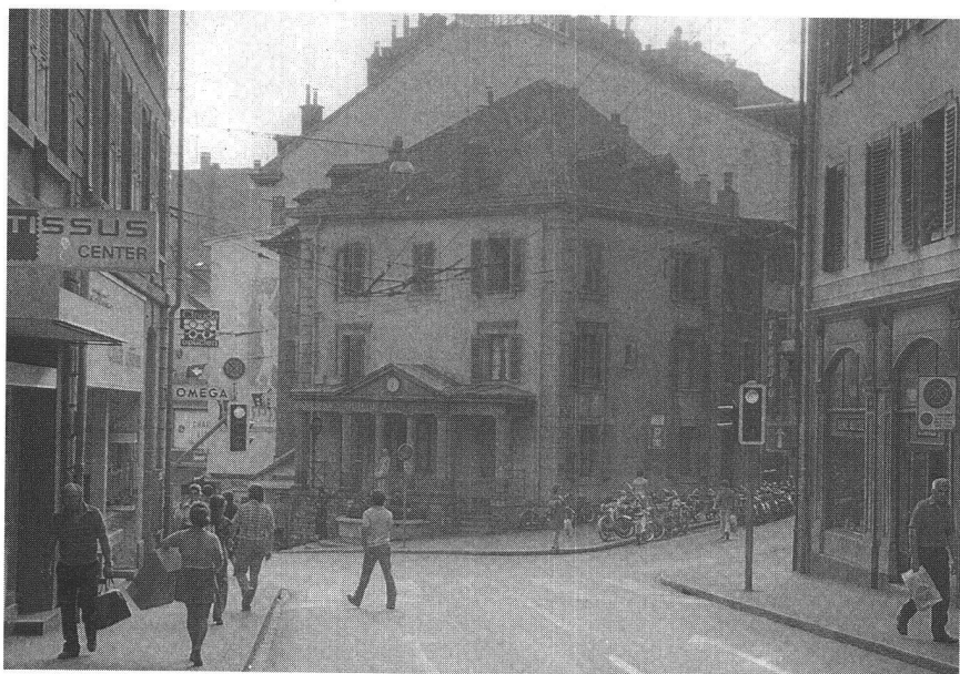
Rue de l'Alé 2, à l'origine poste de police, longtemps occupé par la Guilde du livre, ce bâtiment présente quelques signes d'essoufflement.
