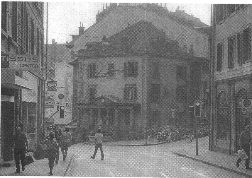
Rue de l'Alé 2, à l'origine poste de police, longtemps occupé par la Guilde du livre, ce bâtiment présente quelques signes d'essoufflement.
