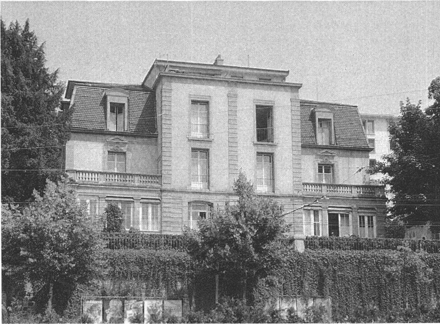
Avenue de la Gare 14-16, la rénovation est imminente...
