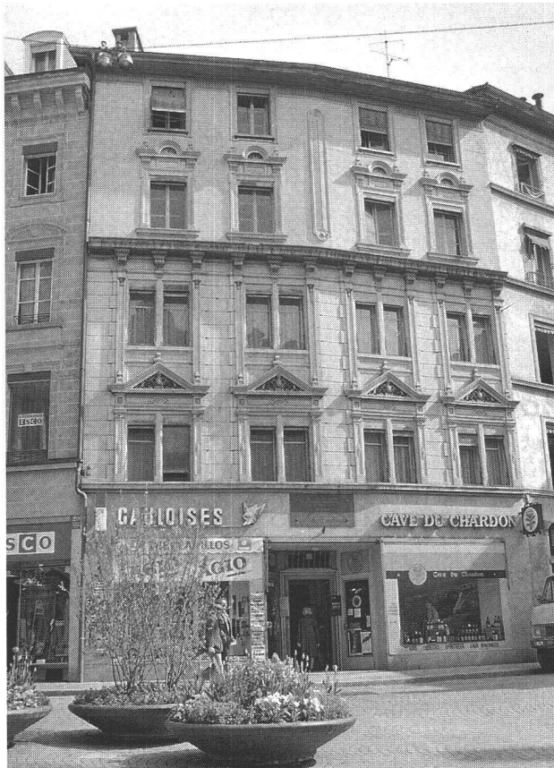
Derrière la belle façade du N° 21 à la Palud, d'importants travaux devront être entrepris.
