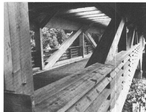
judicieusement les exigences statiques de l'ouvrage. La structure porteuse est une combinaison de nouvelles technologies de triage et d'assemblage du bois lamellé-collé. Cette réalisation exemplaire ouvre une nouvelle ère pour la construction des ponts en bois dans notre pays, grâce au savant dosage de l'architecture et de l'ingénierie.
