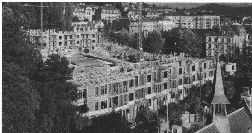
Fig. 6 – Photo de chantier d'un immeuble à l'avenue de Rumine, 1933.
