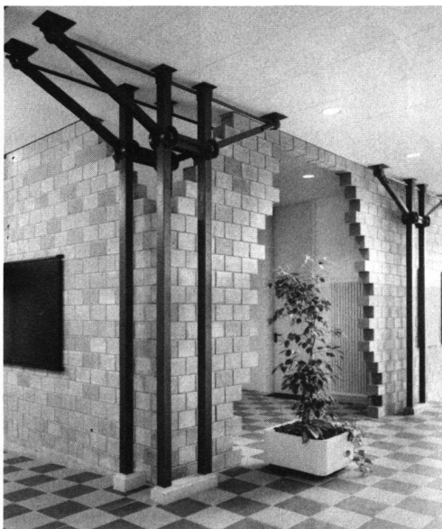
La nouvelle structure porteuse.
