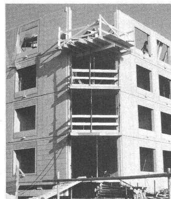
Fig. 25 - Montage sans échafaudage.
