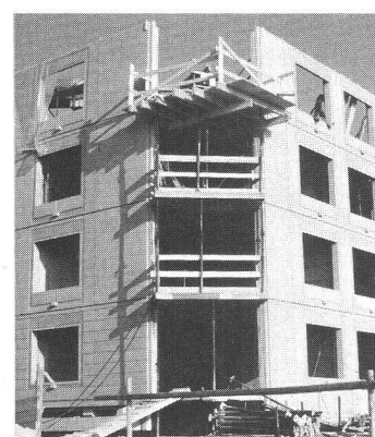
Fig. 25 — Montage sans échafaudage.
