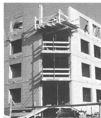
Fig. 25 - Montage sans échafaudage.
