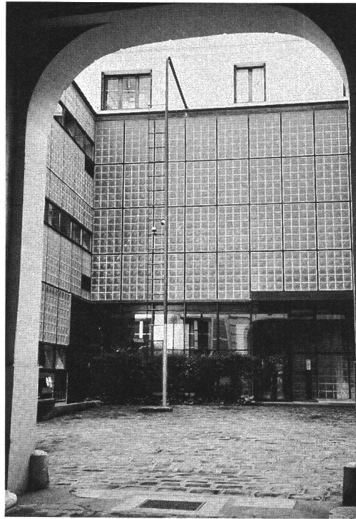
Maison de verre. Façade sur cour.
