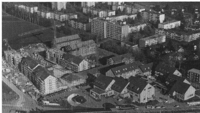
▷ Ensemble résidentiel et commercial de la Chimligasse à Scherzengasse Construction de la deuxième étape: 80 logements réalisés en entreprise intégrale.
