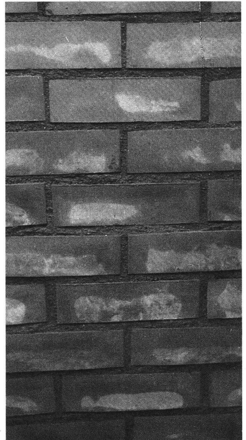
Vue de face d'un mur.
