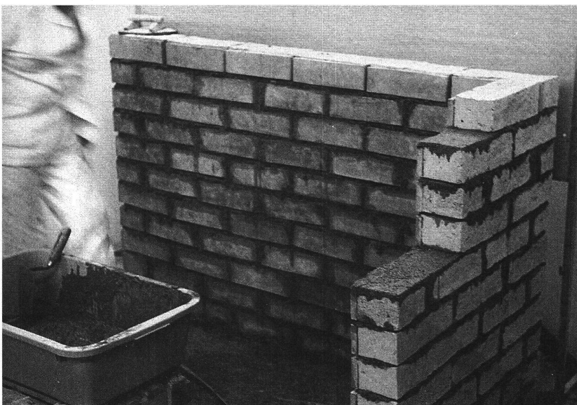
Montage d'un mur.
