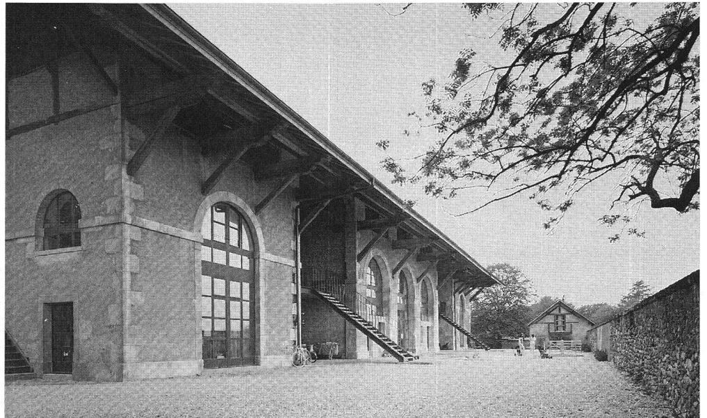
Dans les parties extrêmes du mas, les dalles portent sur des piliers ronds, expression de la nouvelle structure, ou sur des poutres métalliques qui permettent de conserver les corbeaux existants.
