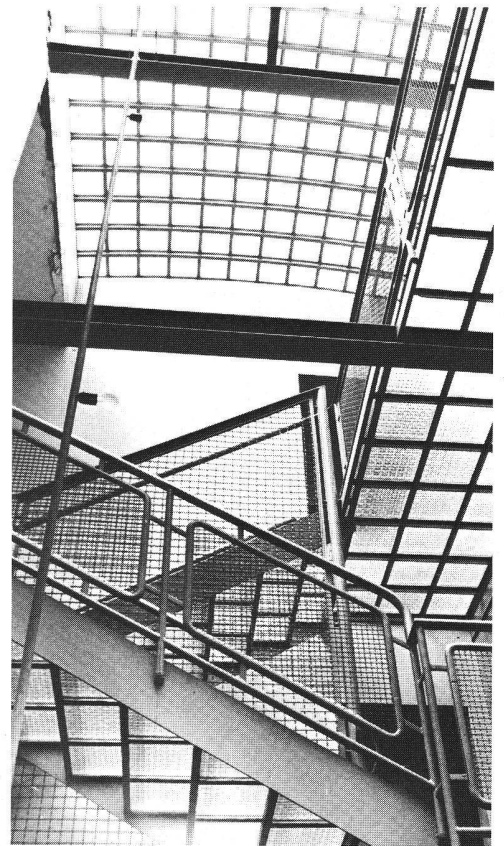
Cage d'escalier. (Photo Catherine Courtiau, 1982.)
