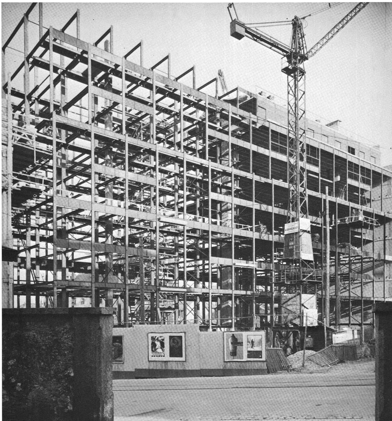
Ossature métallique, côté sud, 1931.
