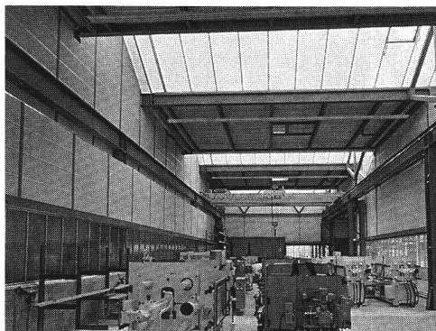
Netstal Maschinen AG, Näfels 5000 m 2 , éléments de toiture SCHICHTEX-spécial et SCHICHTEX-SW, avec peinture structurée, blanc cassé.
