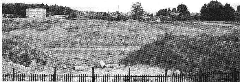
Sur le terrain de la Grangette, les travaux préparatoires viennent de débuter.
