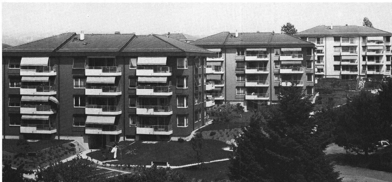
Vue d'ensemble des trois immeubles, sis rue de la Cocarde et chemin de Chantemerle, à Ecublens.
