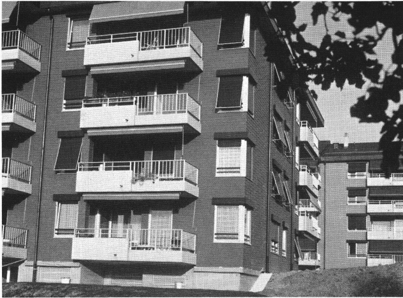
Détail de la façade: on distingue le bardage en ardoises de fibro-ciment sans amiante.
