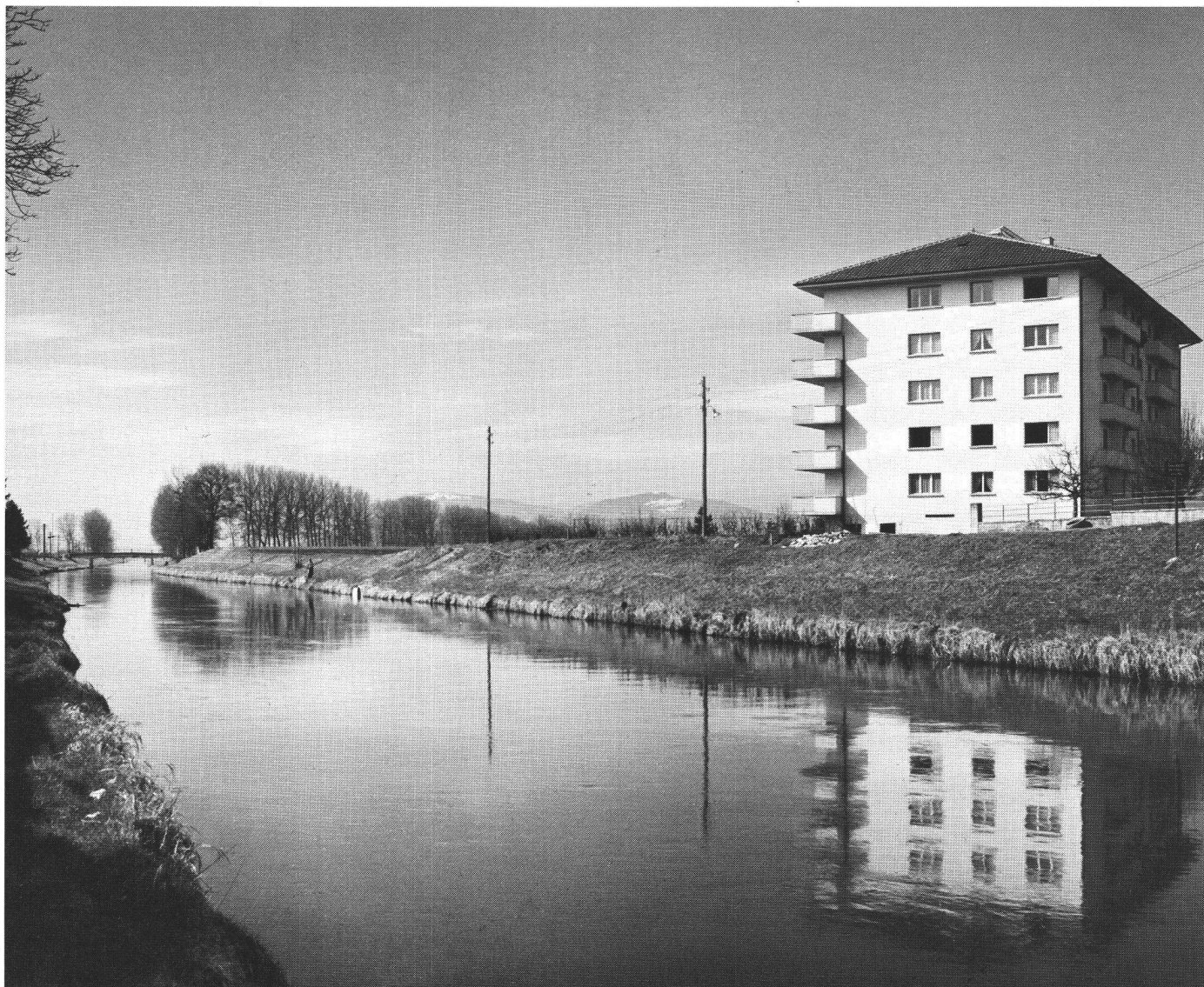
Au bord de la Thièle, bâtiment pour COOP-Vie.
