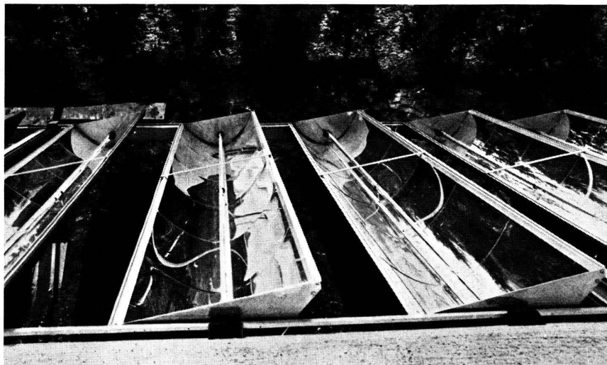
Installation de capteurs à concentration à Grandvaux. Les 52 m 2 de capteurs orientables (est-ouest) sont inclinés à 41° et alimentent un stock de 15 000 l. (Photo: Kaladi.)
