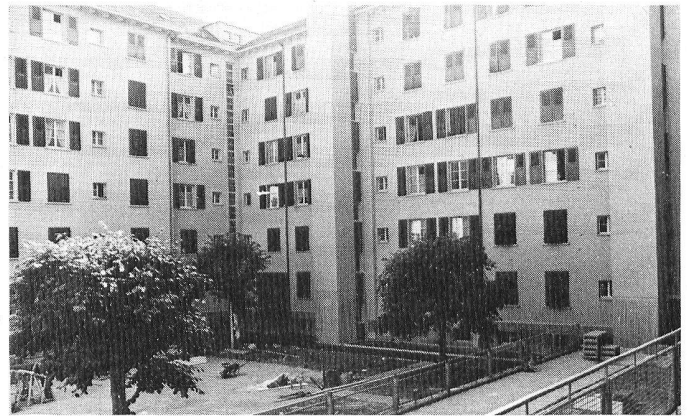
Groupe de Couchirard: la cour avant et après rénovation
