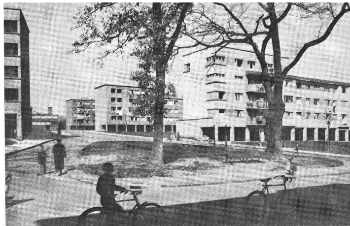
Cité Vieusseux: en haut de l'allée centrale thermique, buanderie collective et bureaux d'administration.
