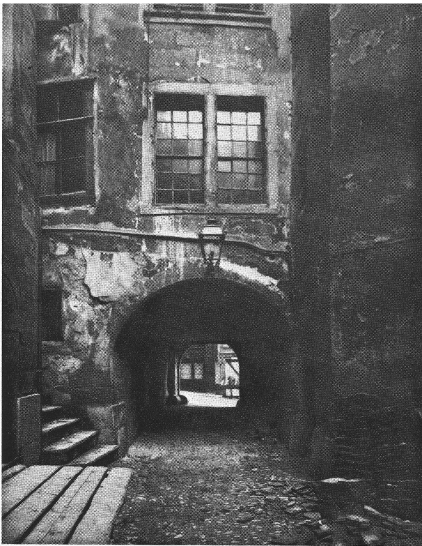
Péllisserie No 5 (en 1916). Le passage de la cour vers la rue. (Cliché Vieux-Genève.)
