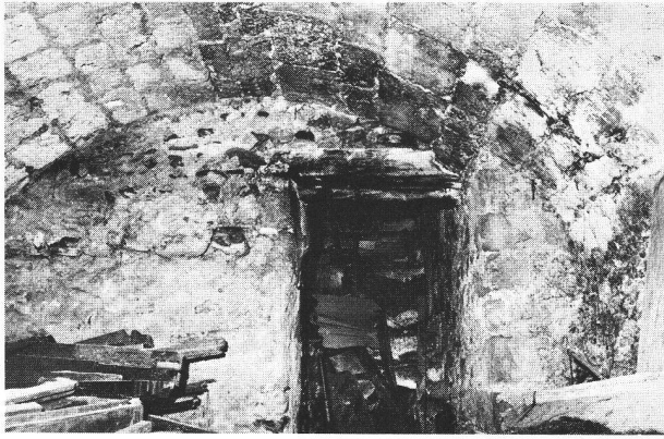
Cave située sous la parcelle II au niveau -1: Accès par un escalier situé à droite de la porte cochère. Murs et voûte en moellons.
