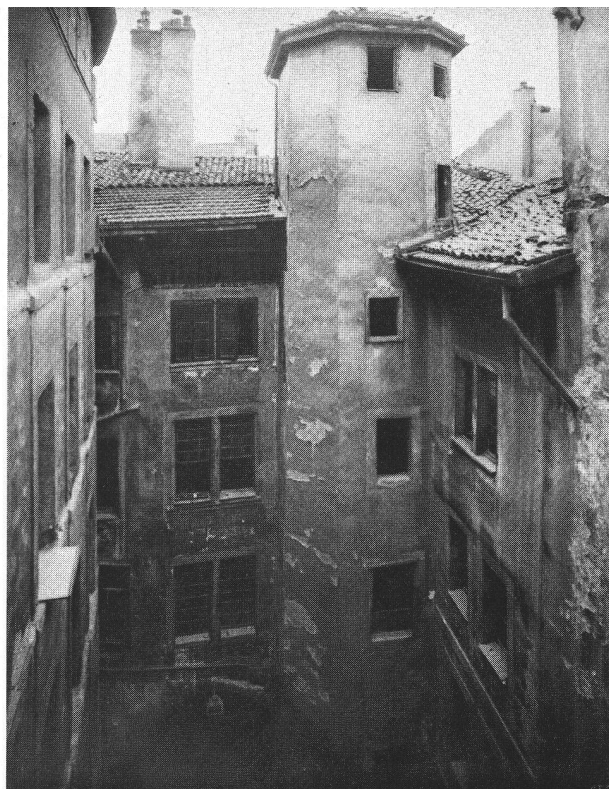
Pélisserie No 5. Cette photo ainsi que la suivante ont été prises à la veille de la démolition (1916). La cour étroite avec son escalier octogonal sur laquelle s'ouvraient les arrières des immeubles (aspect général, XVIIe siècle). (Cliché Vieux-Genève.)
