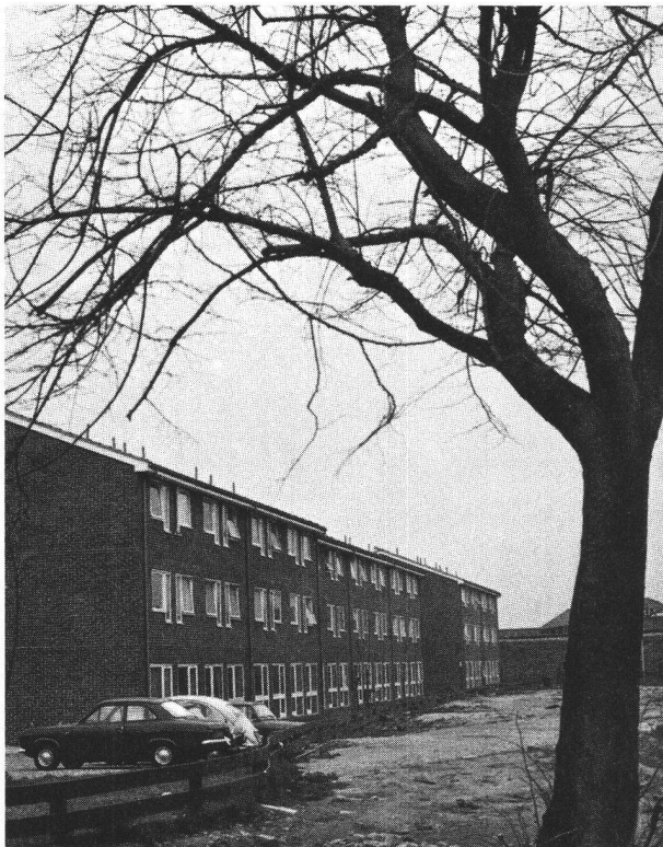
Immeubles du Sanford Estate de Lewisham, à Londres, construits par la Société des habitations coopératives ( Society for Cooperative Dwellings ) à l'intention de jeunes locataires.
