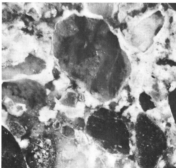
Cave F, mur sud, «série compacte»: blocs relativement gros avec peu d'interstice (quelques schistes, particules translucides, beaucoup de grès).
