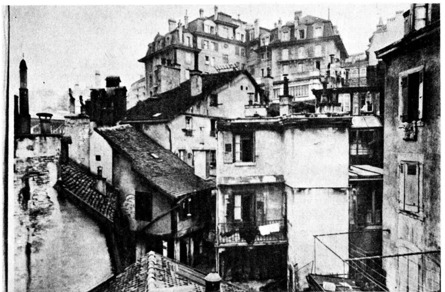
Fig. 38. Cours intérieures de la Cheneau-de-Bourg . Vue prise probablement juste avant la démolition en 1935. Au deuxième plan, immeuble moderne de la SI Colisée-Faucon SA. «On ne saurait plus concevoir, dans l'état actuel de nos idées sociales, une ville assemblant sans réagir les somptueuses maisons des riches et les taudis des malchanceux.» ( Histoire de la Construction à Lausanne , II, p. 17, 1942.)
