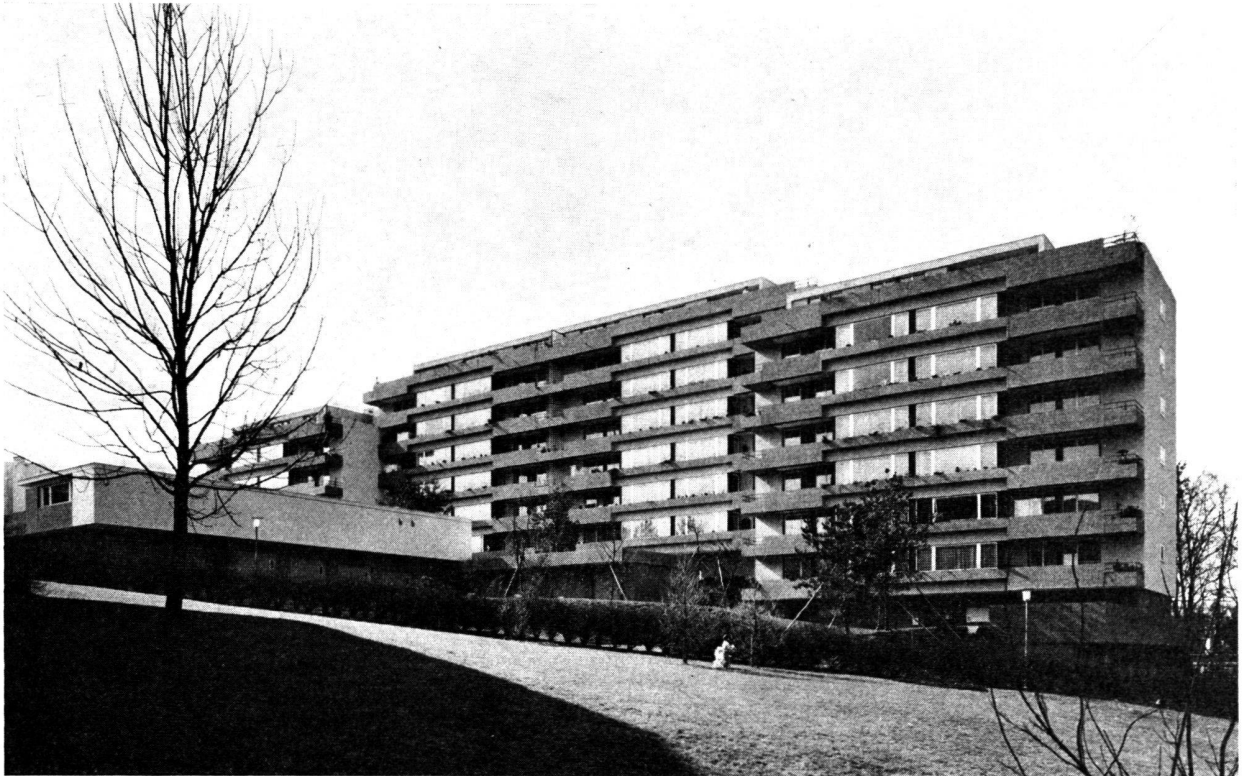
Vue extérieure du complexe immobilier « Chessel », à Schaffhouse. Chaque appartement comprend sa propre installation de chauffage à gaz. (Photo Koch, Schaffhouse.)
