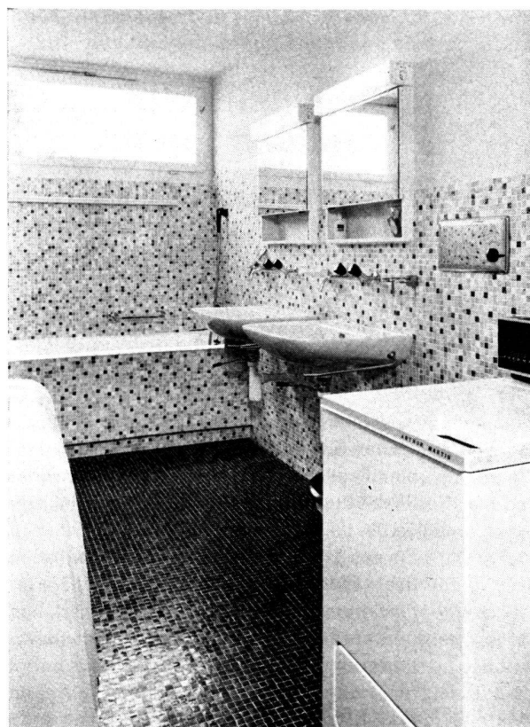
Chaque chambre de bains dispose d'une machine à laver à gaz automatique avec dix-huit programmes. (Photo Koch, Schaffhouse.)
