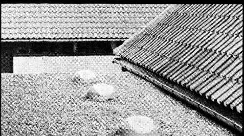
Le ventilateur VELUX pour petits locaux permet aussi à la lumière de pénétrer dans les pièces sans fenêtre - car sa coupole est en verre acrylique transparent.
