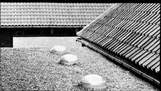
Le ventilateur VELUX pour petits locaux permet aussi à la lumière de pénétrer dans les pièces sans fenêtre - car sa coupole est en verre acrylique transparent.
