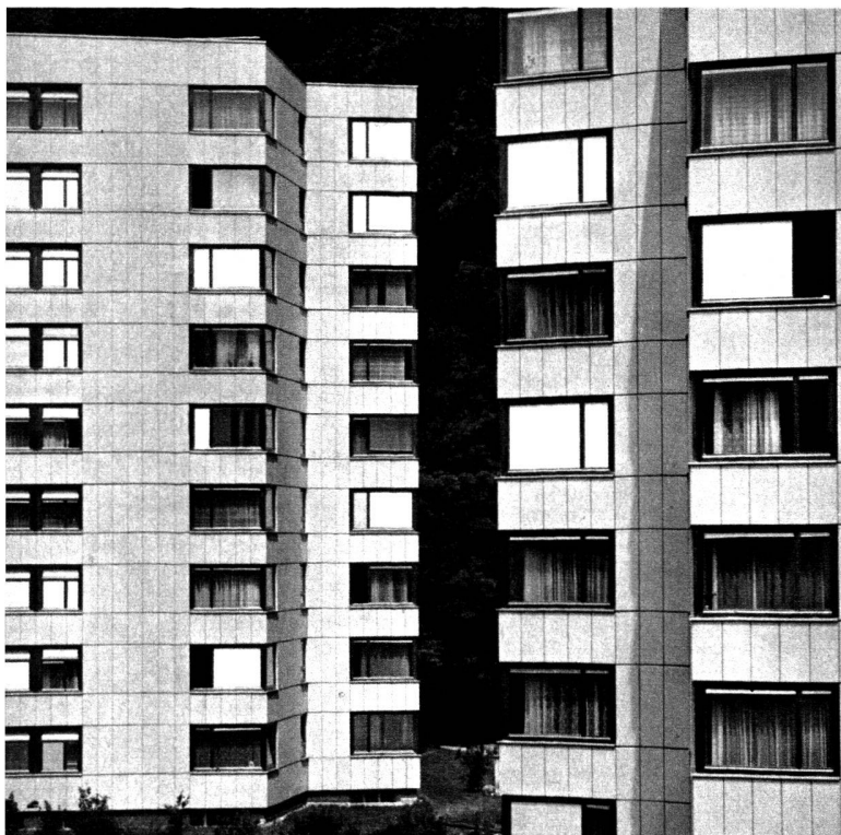
Fondation Le Logement ouvrier, 1963-1968. Quatre immeubles locatifs comptant 225 logements, dont 90 pour personnes âgées.
