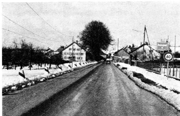
Entrée de zone construite.
