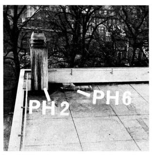
Immeuble à toit plat. La cheminée dépasse de 1 m. 90 la surface de la terrasse. Le toit de l'attique est situé à 2 m. 80 au-dessus de la terrasse. La sortie de cheminée est donc au niveau des fenêtres du logement et les gaz brûlés peuvent s'engouffrer avec le vent dans les chambres.
