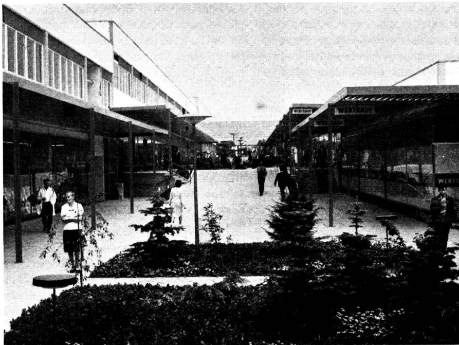
Centre d'achat Main-Taunus près de Francfort. Architecte professeur Schoss- berger, Berlin. Photos Fritz Frischmann, Francfort-sur-le- Main.
