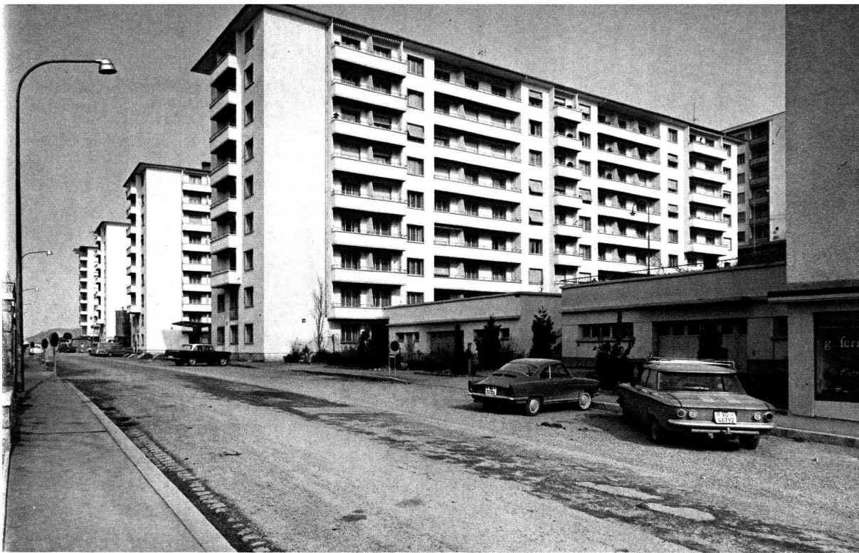
Société coopérative d'habitation de Lausanne Groupes du Boisy I, II, III
