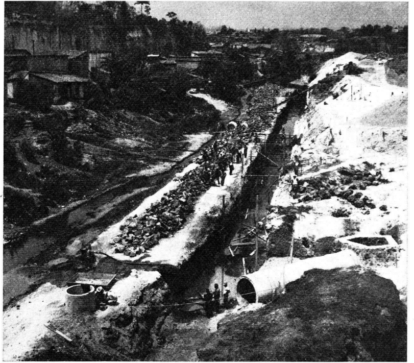
Préparation de l'emplacement du nouveau quartier résidentiel. A gauche, les constructions abandonnées
